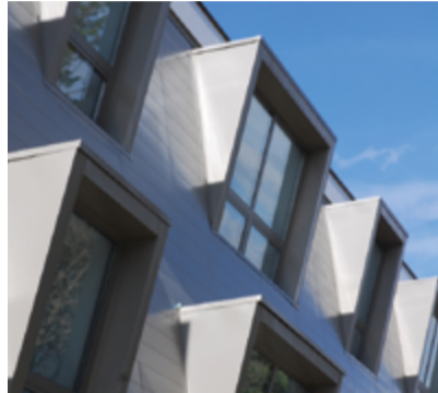
ÉMI Construction Knowledge Center, Szentendre (HU)
